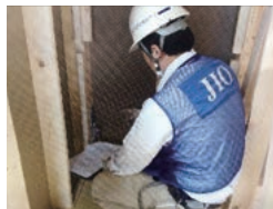
●建物躯体検査
