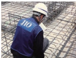
●基礎配筋検査
