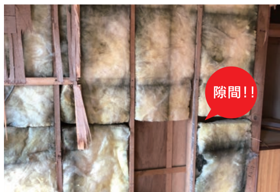
カビの生えたグラスウール カビの重みで断熱材の上部に隙間ができています。
