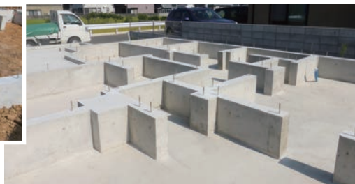
〈ベタ基礎の施工風景〉
