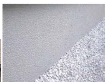
〈弾性塗料施工後〉
