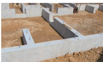
〈布基礎の施工風景〉
