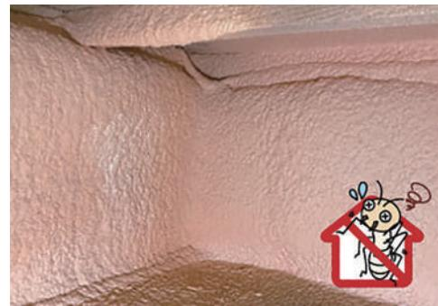
床下に断熱材を敷き詰める『床断熱』は、風通しを良くするために床下に換気口があり、また断熱材が重さで下がってしまい、床と断熱材の間に隙間ができてしまう場合があります。冬は冷たい空気が入り込んだり、夏は湿った空気が流れ込み結露の原因となります。一方、『基礎断熱』は外気の影響を受けにくく基礎と床の空間を「蓄熱層」として有効活用でき、室内の温度と近いため冷暖房の節約にもつながります。
